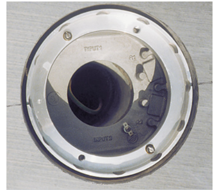
3. Einbau des Aufnahmetopfes Installation of the shallow base
