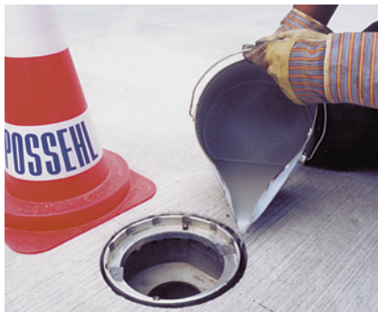
4. Eingießen von cds-Gießbeton UW Sealing with cds-Pouring Concrete UW
