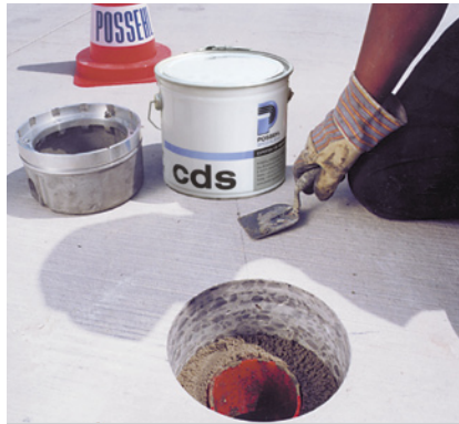
2. Vorbereitetes Bohrloch gefüllt mit cds-Mörtel Prepared borehole filled with cds-Mortar
