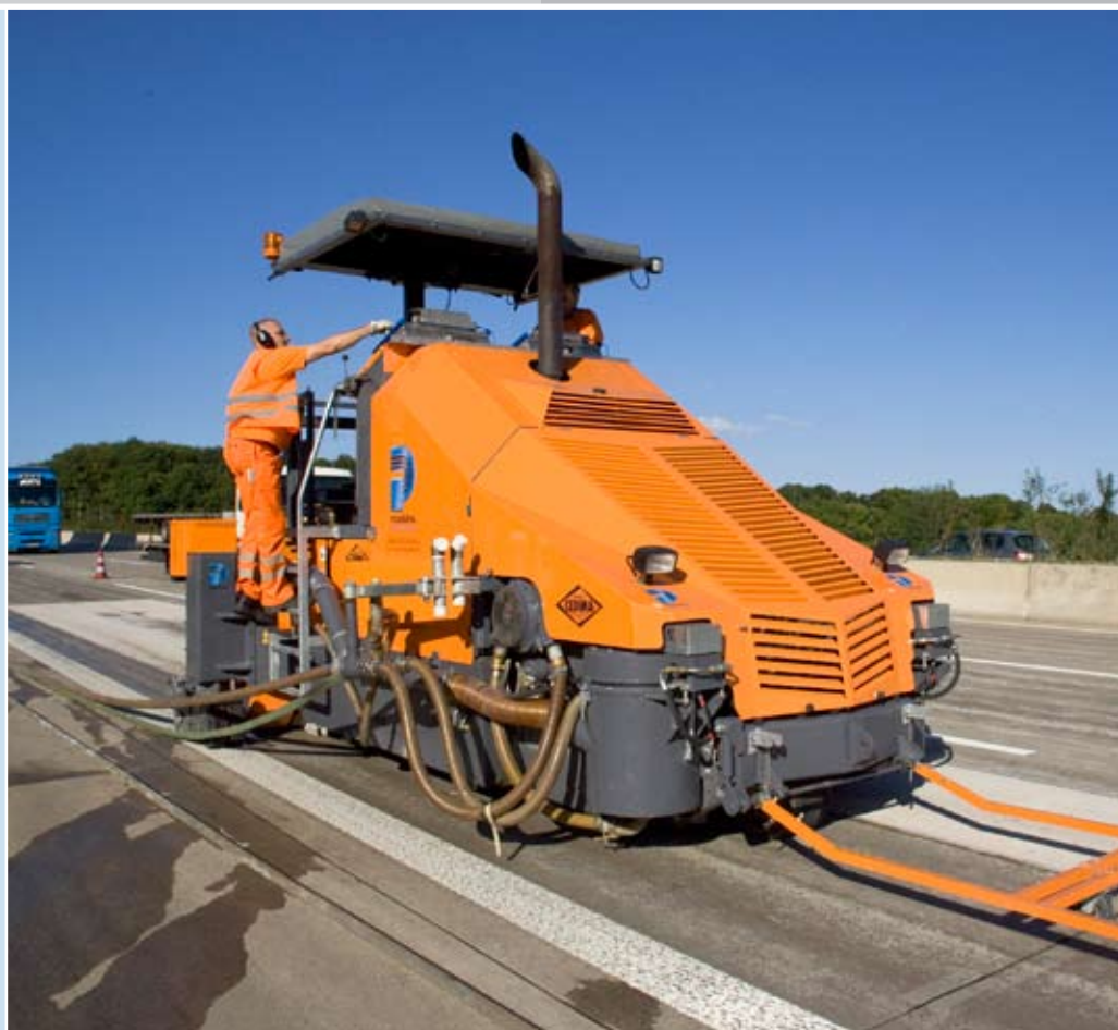
Grinding auf einer Autobahn
