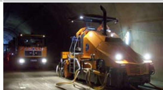
Ebenheitsschleifen in einem Tunnel
