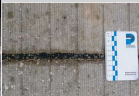
Grinding von Betonflächen, auch über Fugen hinweg
