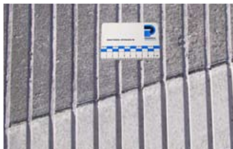
Grooving einer Betonoberfläche
