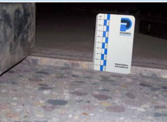
Abschliff einer zu hoch stehenden Betonfahrbahnplatte; hier 1,5 cm
