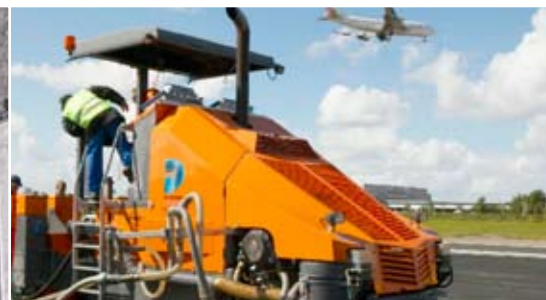
Der BumpCutter im Einsatz auf Flugbetriebsflächen
