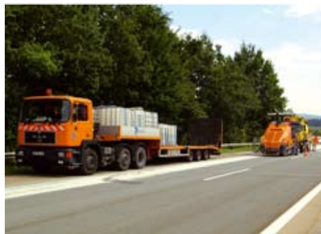
Einsatz des BumpCutters auf einer Autobahn
