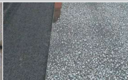
Grinding von Asphaltflächen
