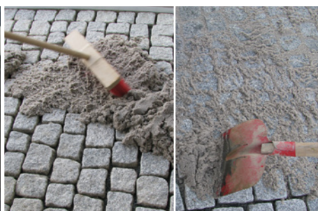
Aufbringen und Verteilen des Materials mit einem Besen oder einer Schaufel
