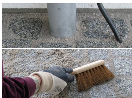
Mit einem Handfeger und einer Maurerkelle kann das Material auch in Ecken und Kanten eingebracht werden
