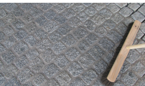
Nachdem das Material eingebracht ist, müssen Mörtelrückstände mit einem feinen Besen entfernt werden
