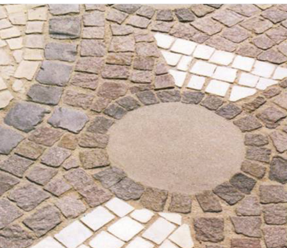
Dekorative Pflasterung mit cds-Fugenmörtel 0-3 P ST dauerhaft verfugt
