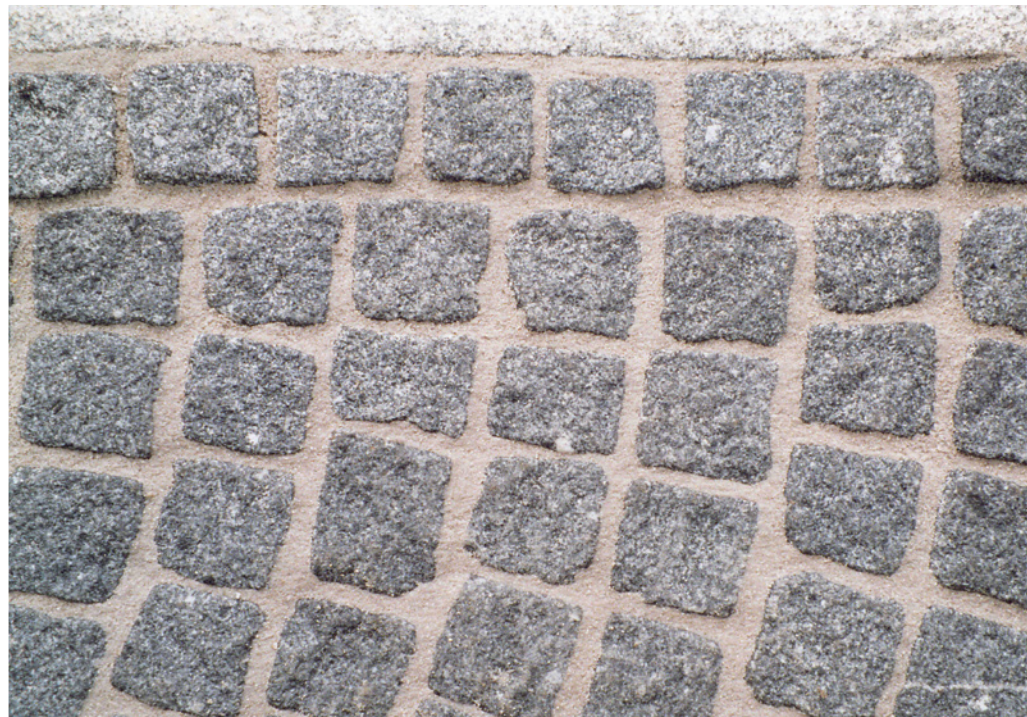
Verfugte Pflasterfläche: Pflasteroberflächen und -kanten bleiben sauber erhalten
