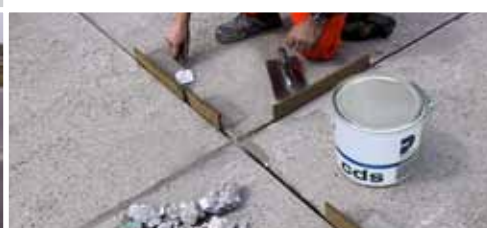
Kantenreparaturen Edge repairs
