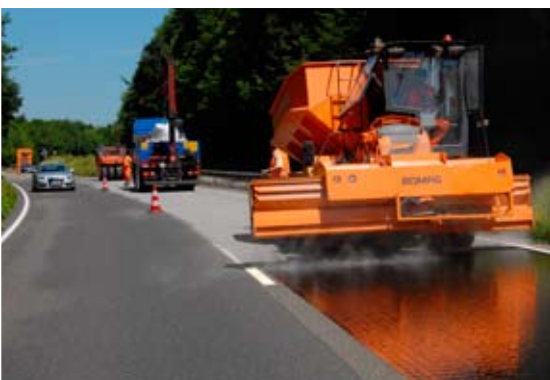
EP-GRIP wird parallel zum fließenden Verkehr aufgebracht. Das Bindemittel bindet die gestreuten Gesteinskörnungen sofort. Die Körner verwirbeln auch dann nicht, wenn LKW die Baustelle passieren
