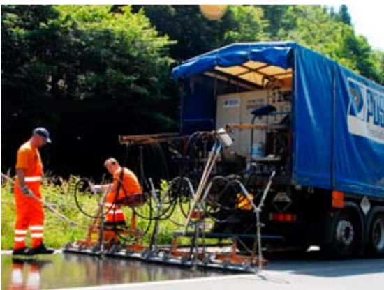
Das Bindemittel wird über Kämme auf die vorbereitete Fahrbahn oder Flugbetriebsfläche aufgetragen.
