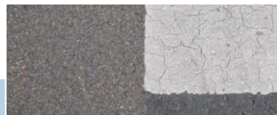
Dank hoher Präzision bei der Belagsapplikation kann die bestehende Markierung weiter verwendet werden.
