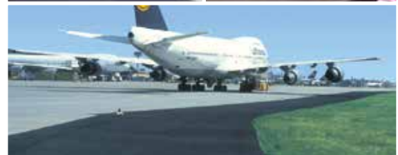
POSSEHL DSK auf Schulterflächen POSSEHL DSK - Thermoplastic Slurry Seal on shoulder surfaces
