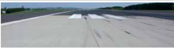
POSSEHL Duroplastische Raubeläge auf Beton POSSEHL Duroplastic Rough Surfacing on concrete
