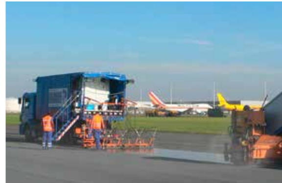
POSSEHL ANTISKID® auf Start- und Landebahnen POSSEHL ANTISKID® on takeoff and landing runways
