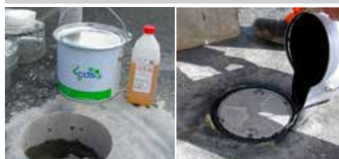
Einbau von Unterflurfeuern mit cds-Produkten Installation of flush-lights using cds-Epoxy Systems
