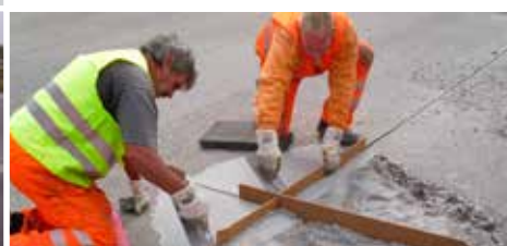
Kantenreparaturen Edge repairs
