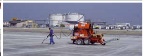
Fugen- und Rissevergießen Joint sealing and crack filling
