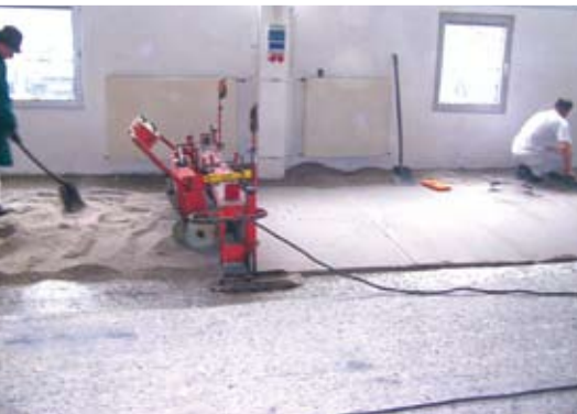
Laserunterstützter Einbau von Epoxidharz-Estrich
