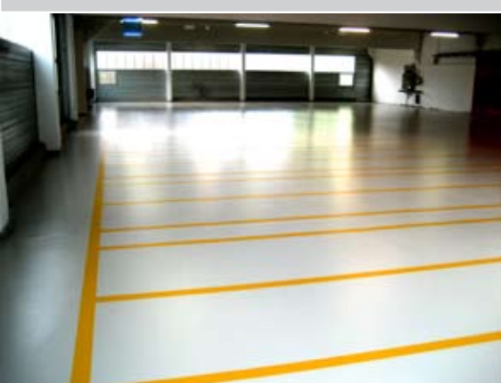
Dauerhafte Markierung aufgrund durchgehender Pigmentierung des Epoxidharz-Belages
