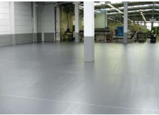
POSSEHL-Industrieboden: Abriebfester Belag in einer Lagerhalle
