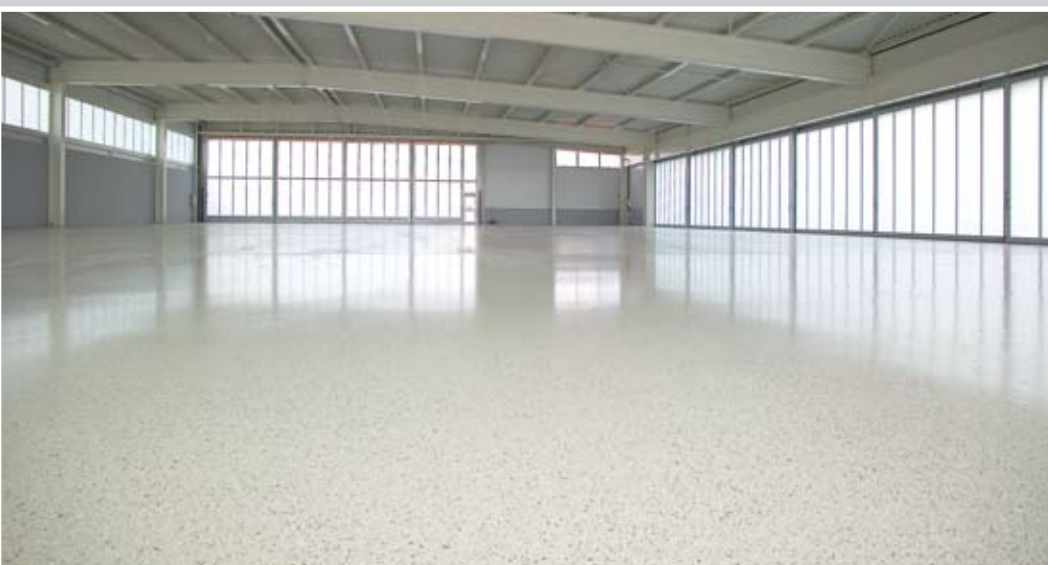
Hochbelastbarer POSSEHL-Industrieboden mit Chipeinstreuung in einer Flugzeugwartungshalle
