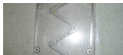
Wasserdichte Stahl-Edelstahl-Fugenkonstruktionen für Schwerlastverkehr
