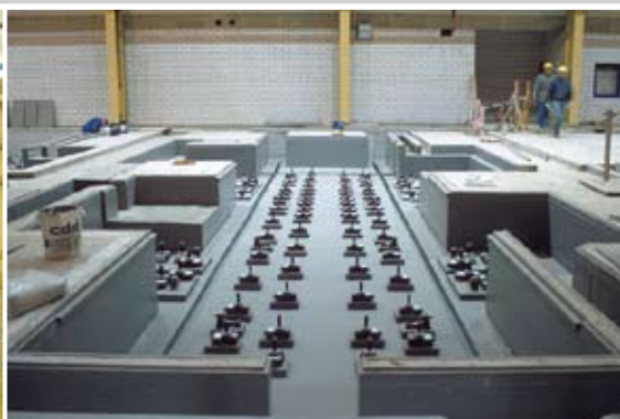
WHG-Schutzbeschichtung für Maschinenfundamente
