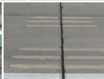
Verdübelung nach erfolgter Unterpressung
